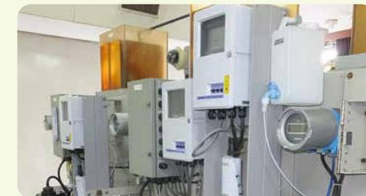
24時間連続して浄水処理の段階ごとに水質異常がないか自動で水質測定、監視を行っており、万が一異常が生じた場合に、すぐ対応できる体制を整えています。
