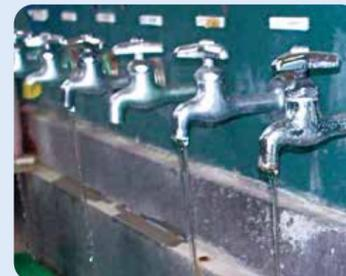
浄水場では水づくりの工程ごとの水を採水し毎日検査を行います。
