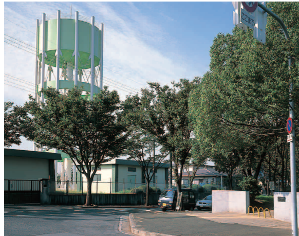
●鶴山台配水場
