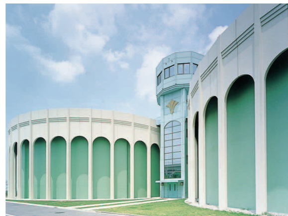
●中央受配水場
