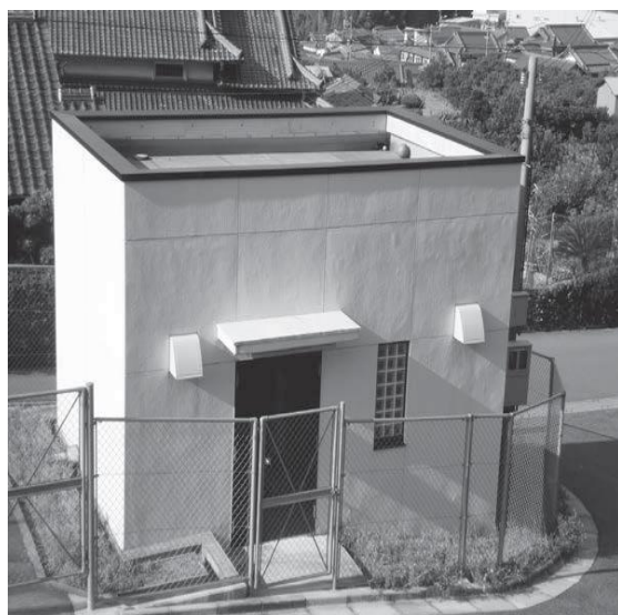
坪井加圧ポンプ所
