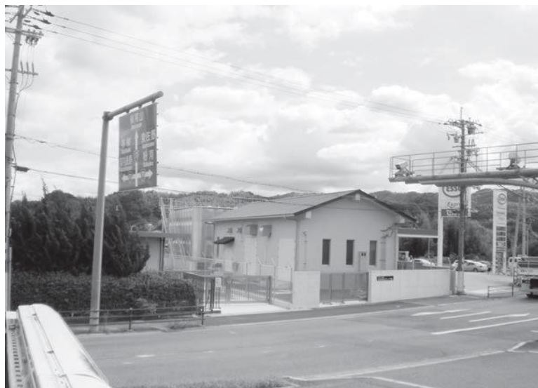
仏並加圧ポンプ場
