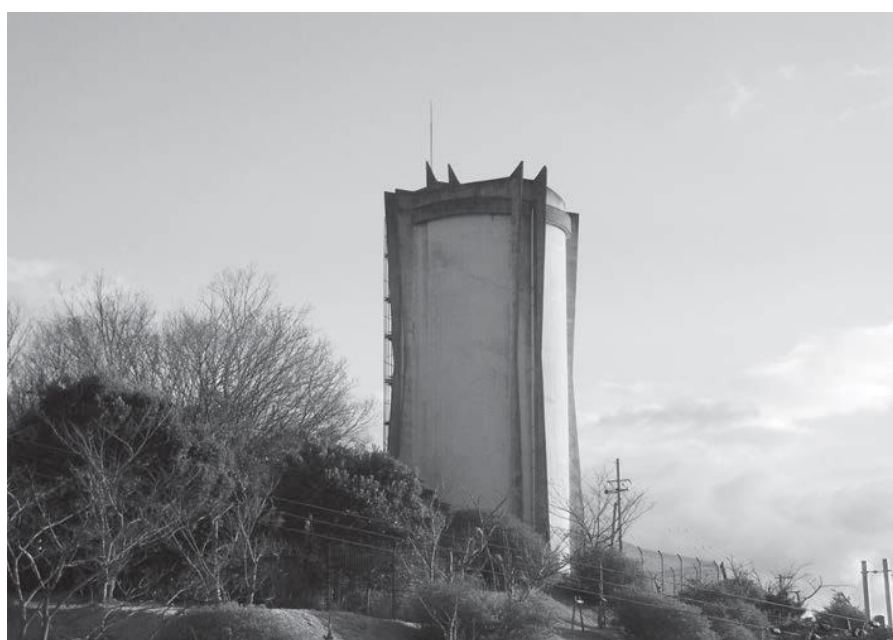
光明台高区配水塔
