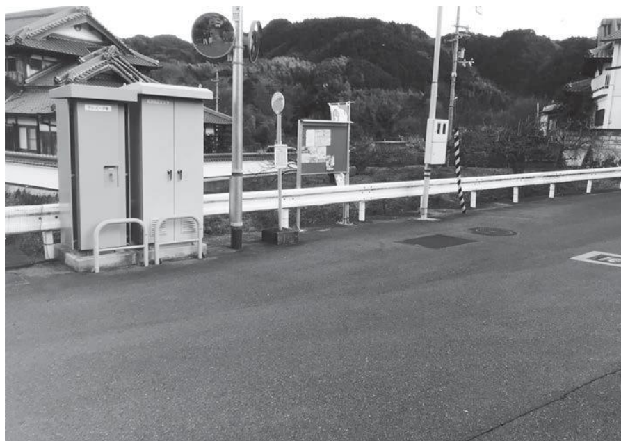
九鬼加圧ポンプ所
