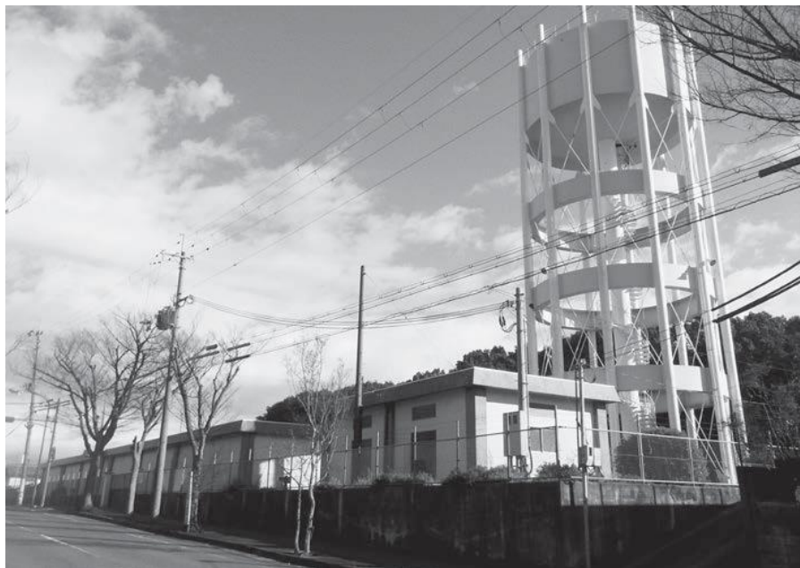
鶴山台配水場
