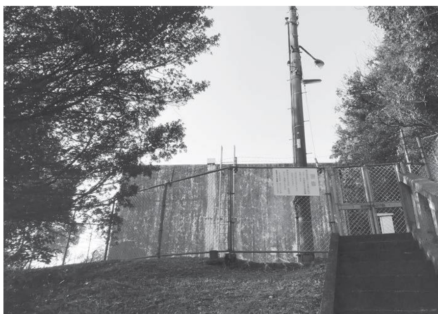
南面利配水池
