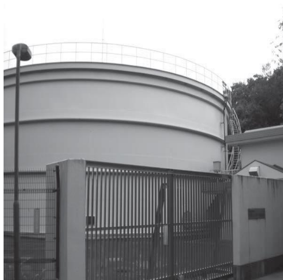
テクノステージ配水池
