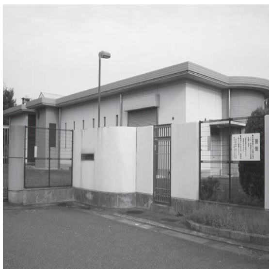
テクノステージ加圧ポンプ場
