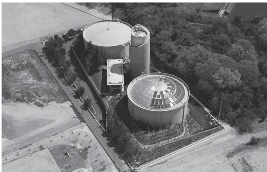
はつが野配水場
