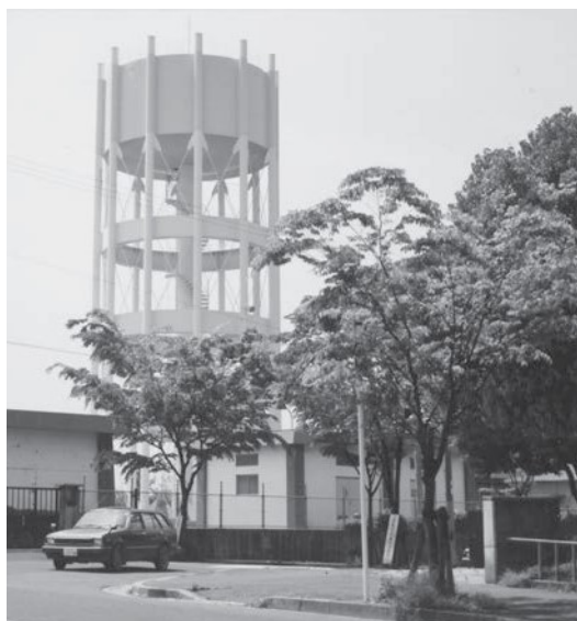
鶴山台配水場
