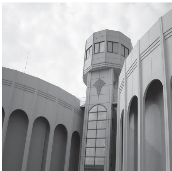
中央受配水場
