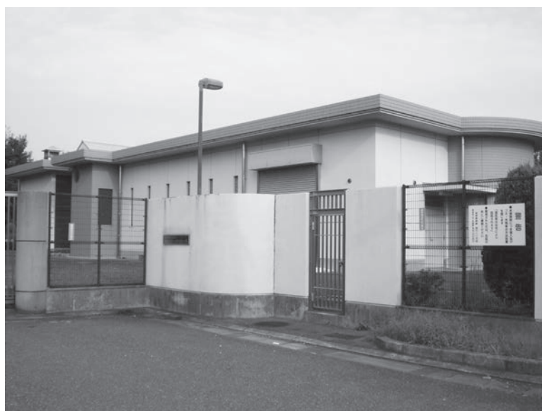
テクノステージ加圧ポンプ場
