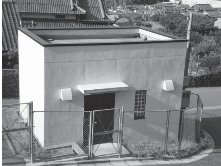
坪井加圧ポンプ所
