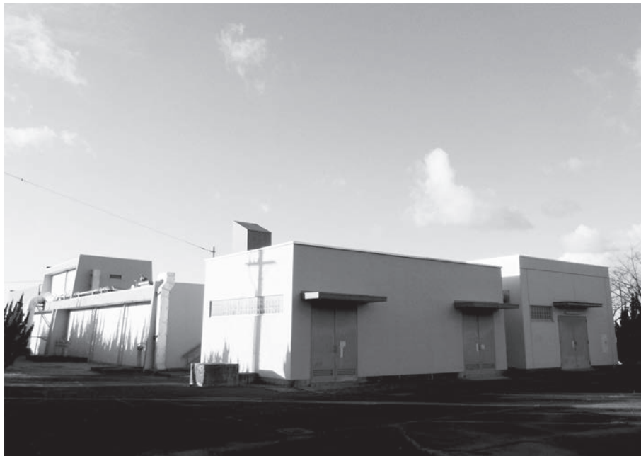
光明台高区配水場
