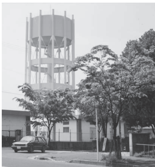
鶴山台配水場
