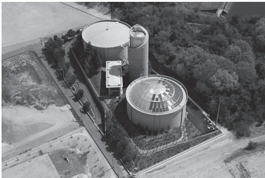
はつが野配水場
