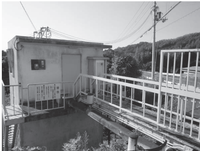
善正加圧ポンプ所
