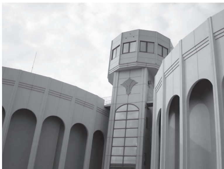
中央受配水場
