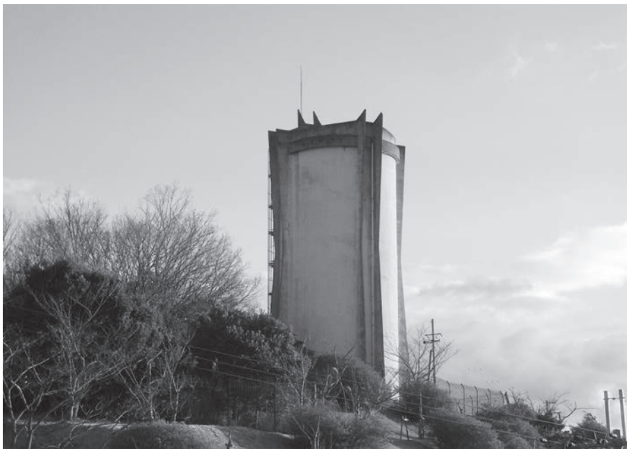
光明台高区配水塔
