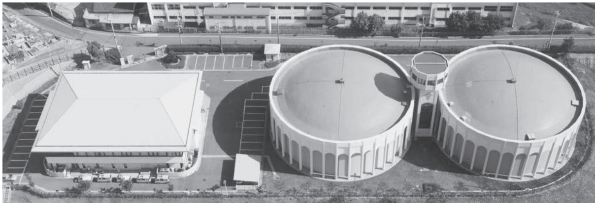
中央受配水場
