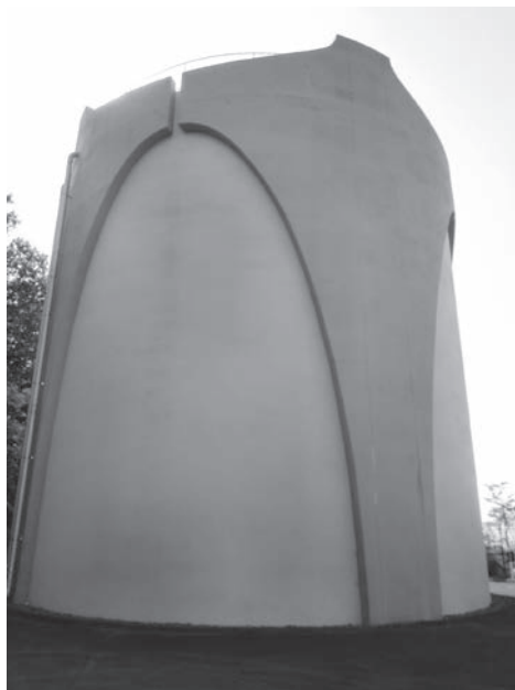
みずき台配水塔
