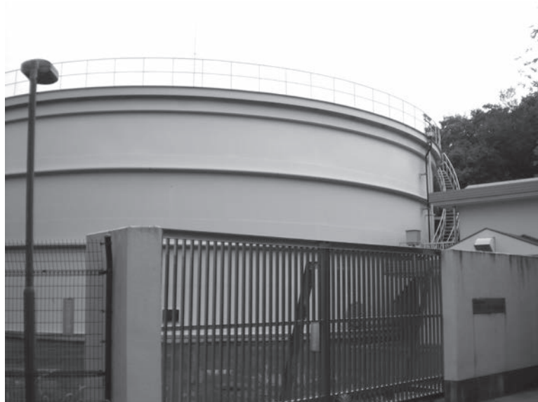
テクノステージ配水池
