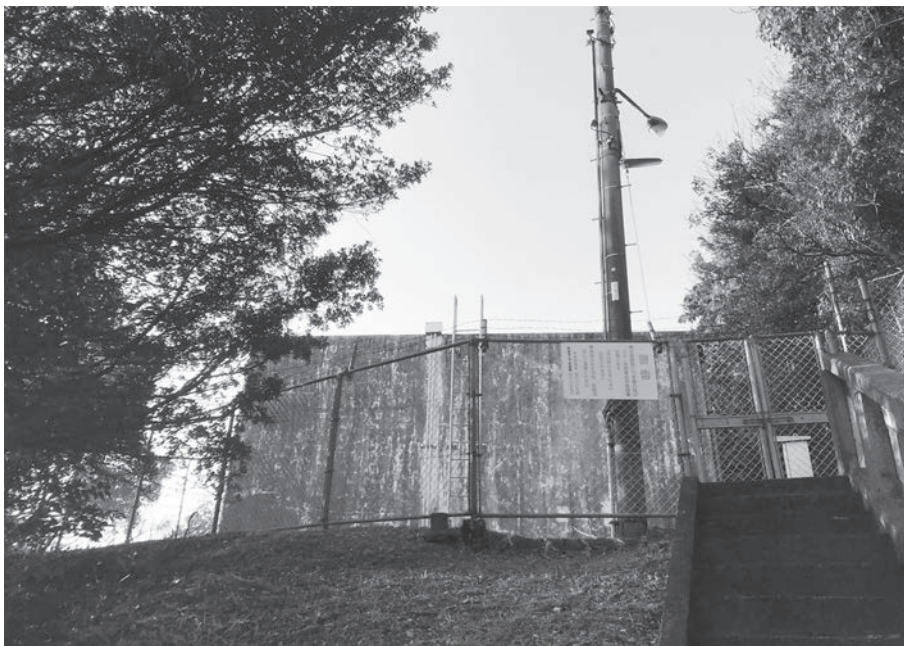
南面利配水池
