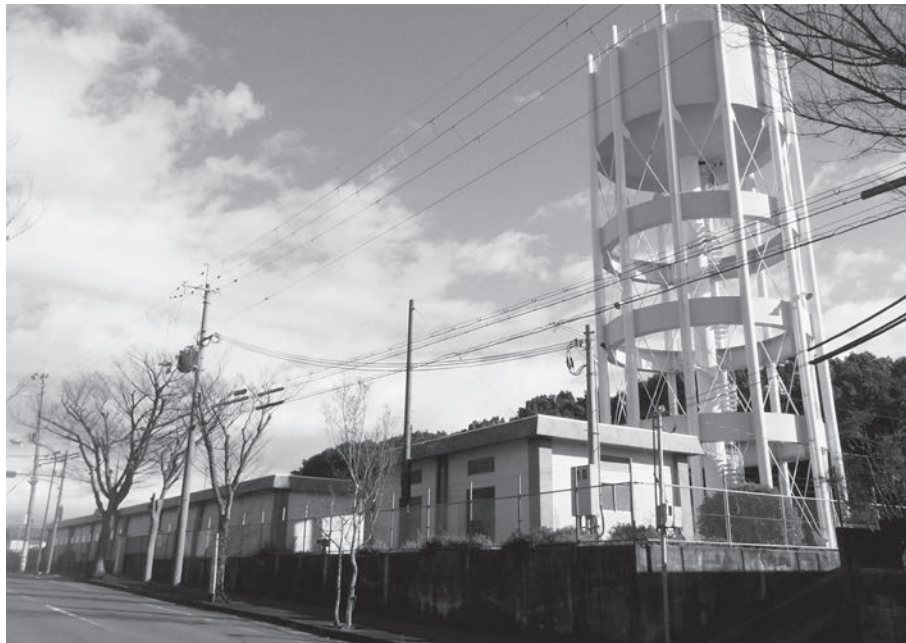
鶴山台配水場
