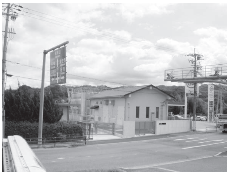
仏並加圧ポンプ場
