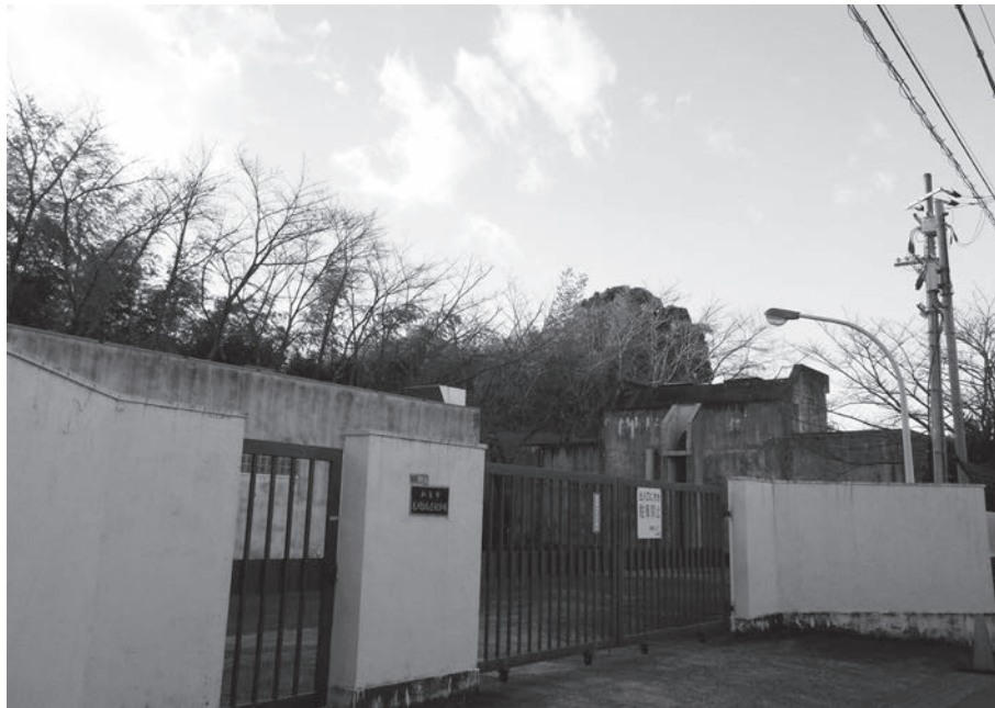
光明台低区配水場
