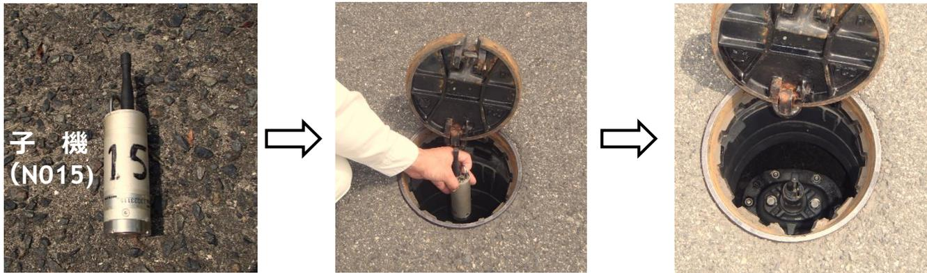
子機は20本あるので一度に20箇所の調査が可能です。子機1本で半径約150メートル四方の漏水の有無が調査できます！！
